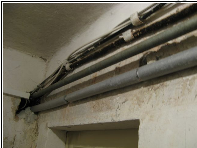
Obr./13/ - Rozvody teplé vody
