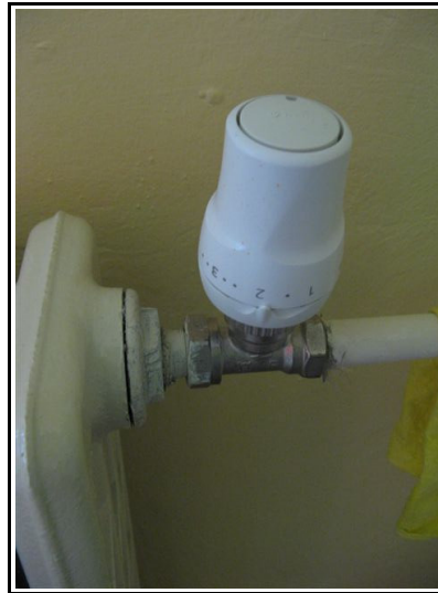
Obr./10/ - Termostatický ventil
