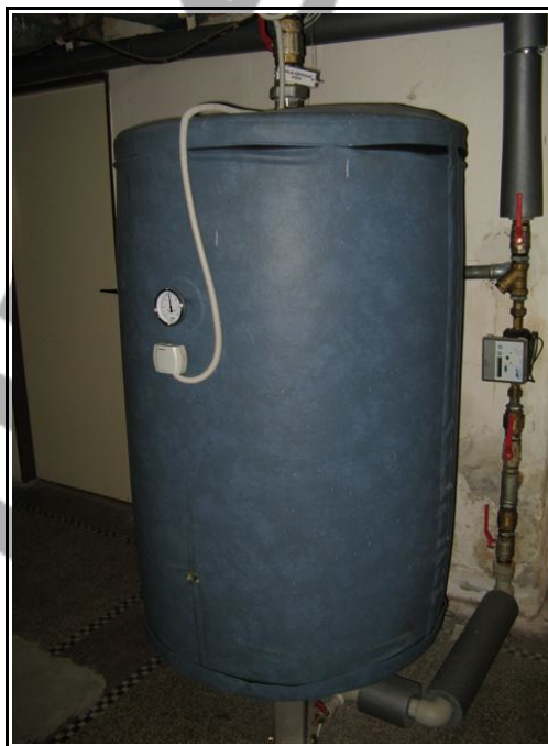
Obr./12/ - Zásobník na teplou vodu v Honlově domě
