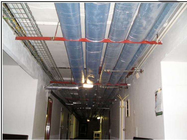
Obr./8/ - Pohled na horizontální rozvody tepla
