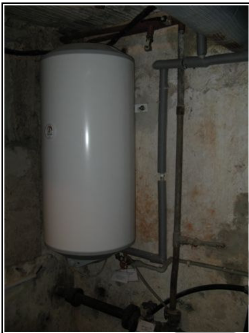
Obr./11/ - Elektrický ohřívač na teplou vodu v domě Janovského
