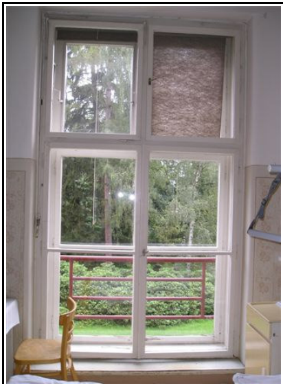
Obr./19/ - Dřevěné špaletové okno
